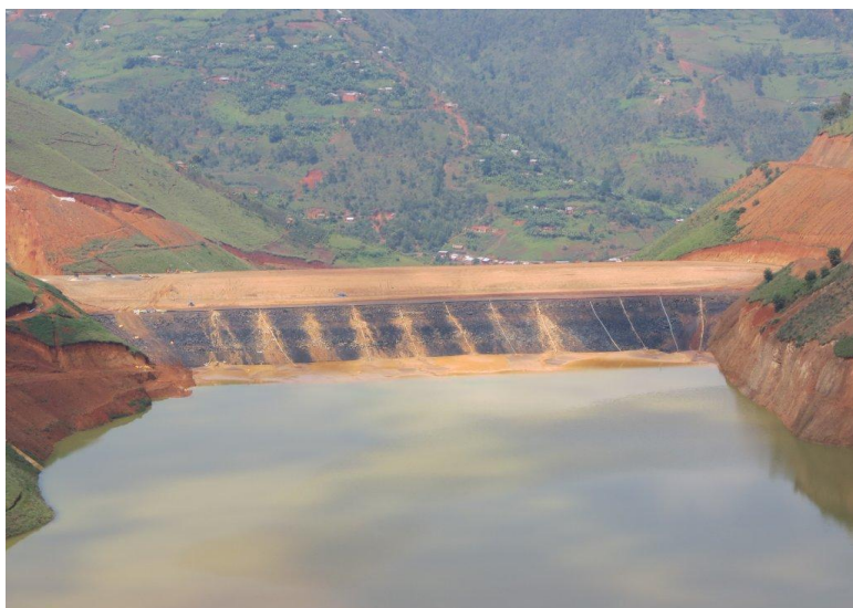
Bassin (lac artificiel) pour le rejet des effluents
